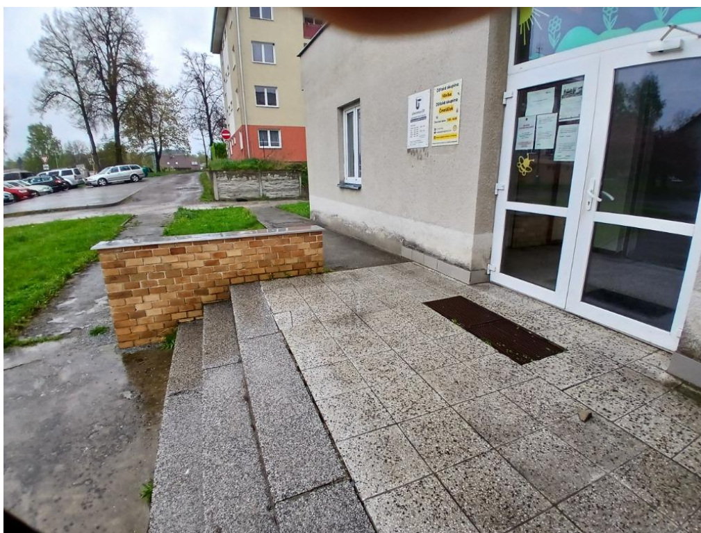
Vstup do části budovy, kterou využívá ÚP ČR
